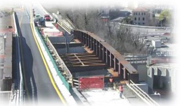
Viadotto San Bernardo
